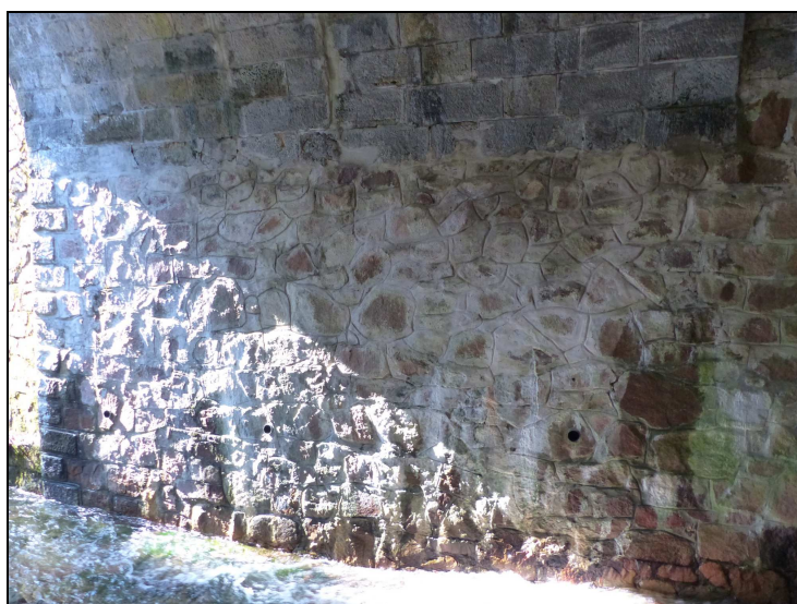
Foto č. 3 Opěra O 01 vpravo Prúsaky s výluhy zdivem opěry
